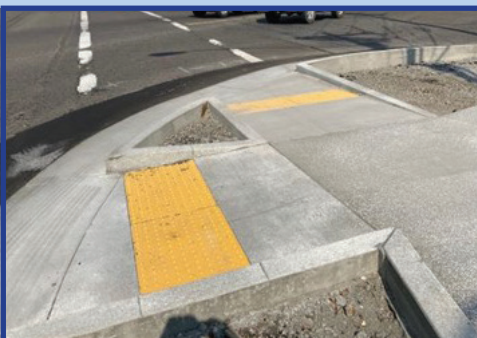
Improved curb ramps at intersections and crosswalks Rampas de acera mejoradas en intersecciones y los paso de peatones
