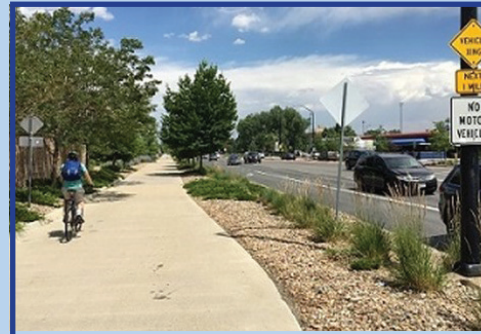
12-foot shared use path separated from roadway for use by pedestrians and bicyclists Camino de uso compartido de 12 pies separad a lo de carretera para uso de peatones y ciclistas
