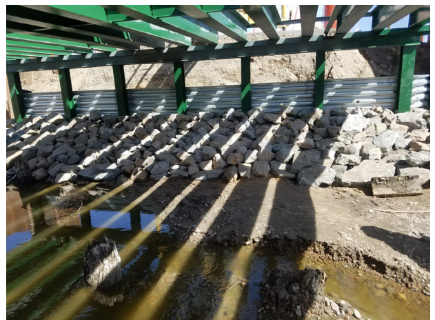
Trabajo completado bajo la plataforma, abril de 2018
